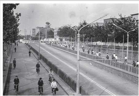
● 中原路地下通道
