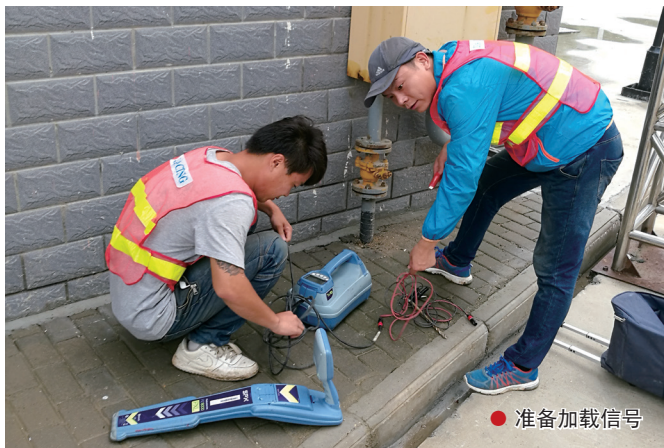
● 探测地下管线
