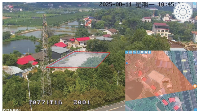
图10 高空铁塔视频监控效果
