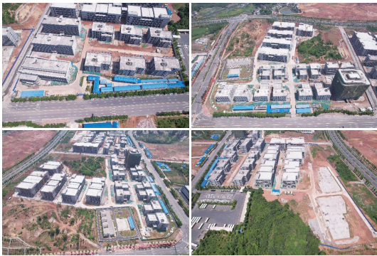
图8 无人机拍摄实地照片
