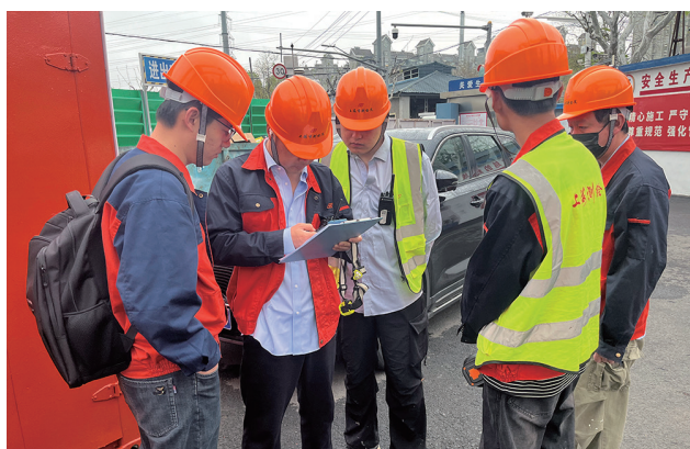
●完成上海桃浦污水厂地下隧道贯通精密测量 李锦/摄
