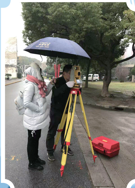
● 2018年12月13日，一场雨雪过后，河南五格勘测信息技术有限公司工作人员正在为驻马店市农展馆施工放线。（邹杨/摄）
